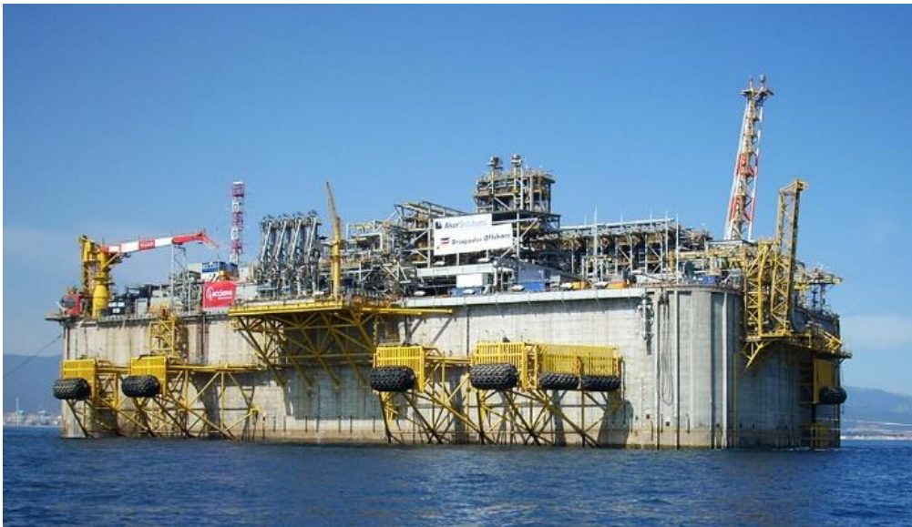
Figure 4 Adriatic LNG offshore terminal
