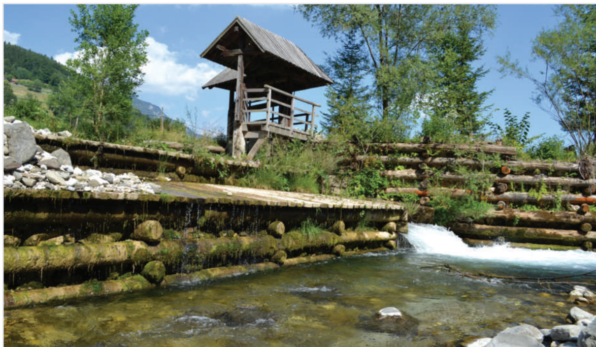
Fotografija 2: Lesena kašta ali Kranjska stena je tradicionalna tehnika za zmanjševanje erozijskega delovanja voda. Naši predniki so to tehniko uporabili pri gradnji jezov in mlinščic za pogon mlinov in žag. Te ureditve ne ogrožajo lokalnega habitata ampak ga bogatijo. Kranjska stena je tudi zaradi tega zasluženo vpisana v Register žive kulturne dediščine RS.
